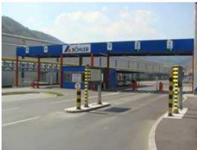
Portálový monitor radioaktivity – vjezd do závodu Böhler
